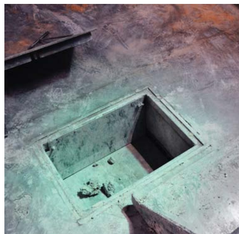
Verschließbare Bodenöffnung mit den Maßen 60 cm x 40 cm für den Materialabwurf.
