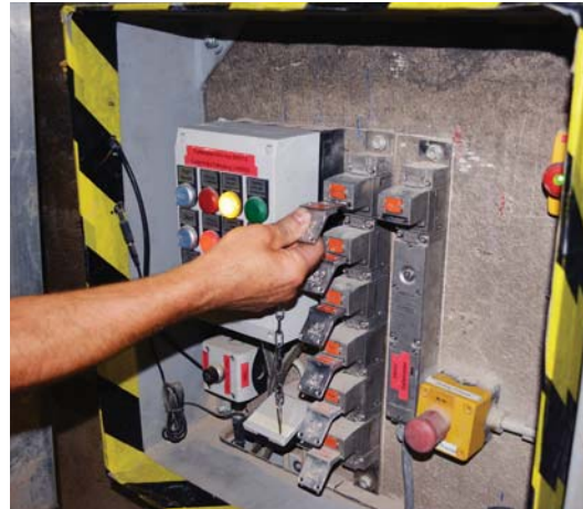
Erst wenn alle Türen verriegelt sind, kann der Bediener den STS-Schlüssel mit dem Zündschlüssel entnehmen.
