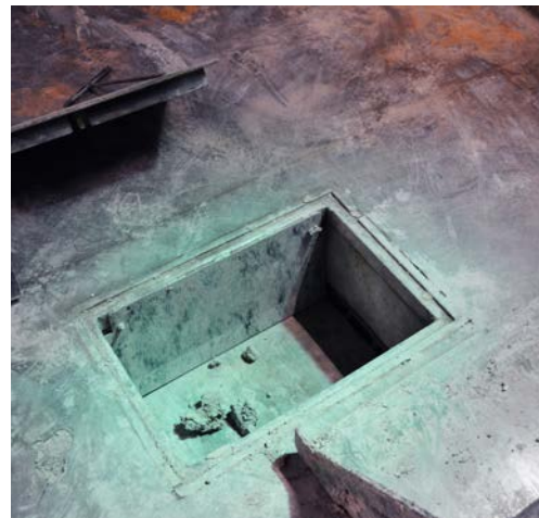
Verschließbare Bodenöffnung mit den Maßen 60 cm x 40 cm für den Materialabwurf.
