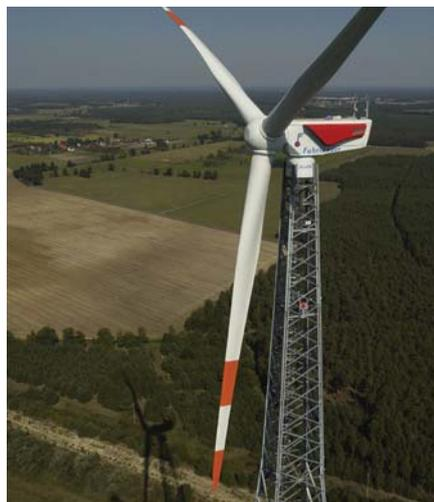
Von W2E geplante Windenergieanlagen sind in den USA, in Europa und in Asien installiert. Die 2006 in Laasow errichtete W2E-2.5/90 war mit einem 160m hohen Gitterturm für 10 Jahre die höchste Anlage der Welt.
